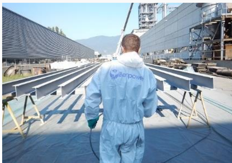
Tinteggiatura previa spazzolatura delle strutture metalliche, muri e porzioni della copertura
